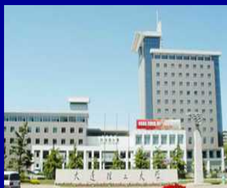
大連理工大学国際会議中心
