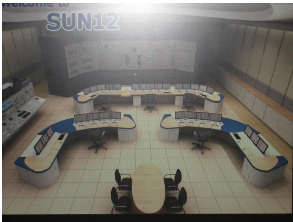
写真 6 中央制御室の配置
