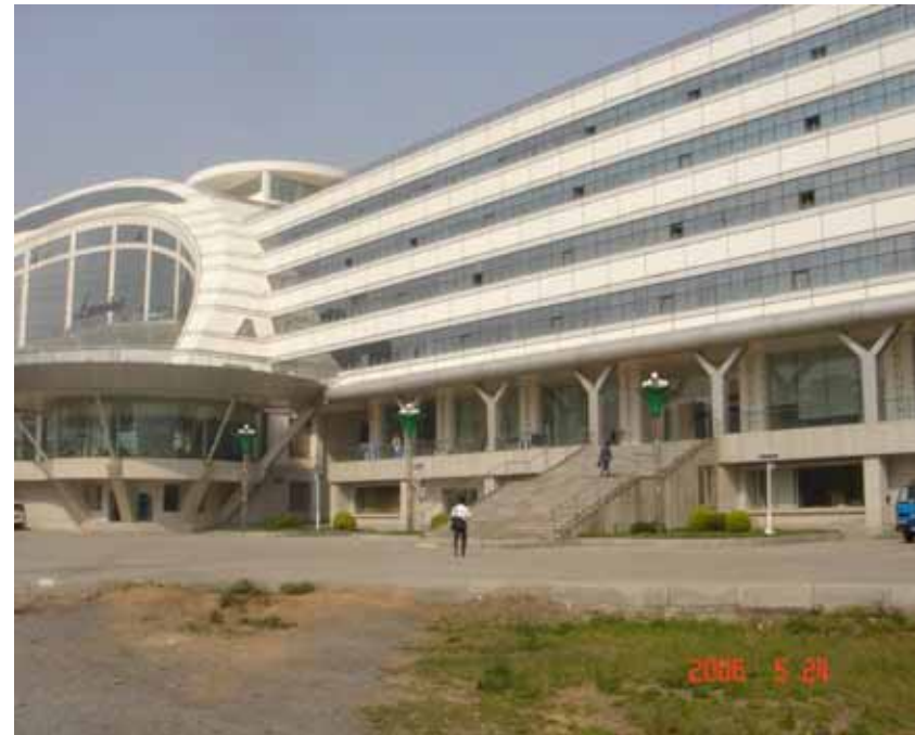
大連理工大学本部キャンパス 近傍の新科技园内の路明ビル (2CIS社は5階フロア)
