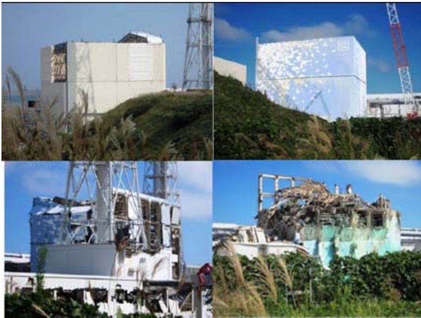
福島第一発電所遠景（左上から時計周りに1,2,3,4号炉。平成23年10月頃撮影。東電提供）
