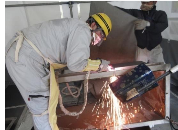
ふげん実機材を用いた解体訓練
