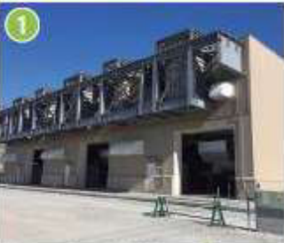
ガスタービン発電機建屋
