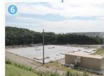
緊急時淡水貯槽 海拔30mの高台に緊急時淡水貯槽を設置
