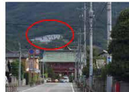
景観を乱すパネルの設置
