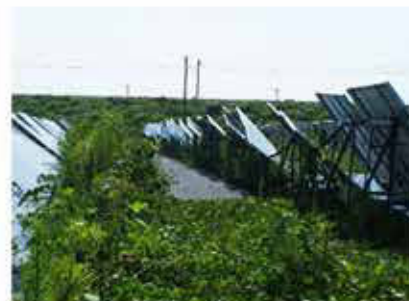
不十分な管理で放置されたパネル
