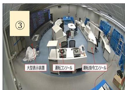
2011年3月の東電福島事故により長期の運転休止を余儀なくされた関電高浜1,2号炉と美浜3号炉はその再稼働に合わせて、まず古いアナログ型計装制御盤①を全面撤去し②、その後最新のデジタル型制御盤③に更新されました。この発表は、同様の工事を計画中の中国、韓国の参加者から非常に関心を寄せられました。
